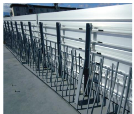
アルミ合金製残存型枠
