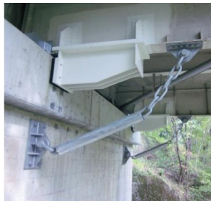
チェーン型落橋防止装置
