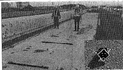
検測の様子とターゲット
